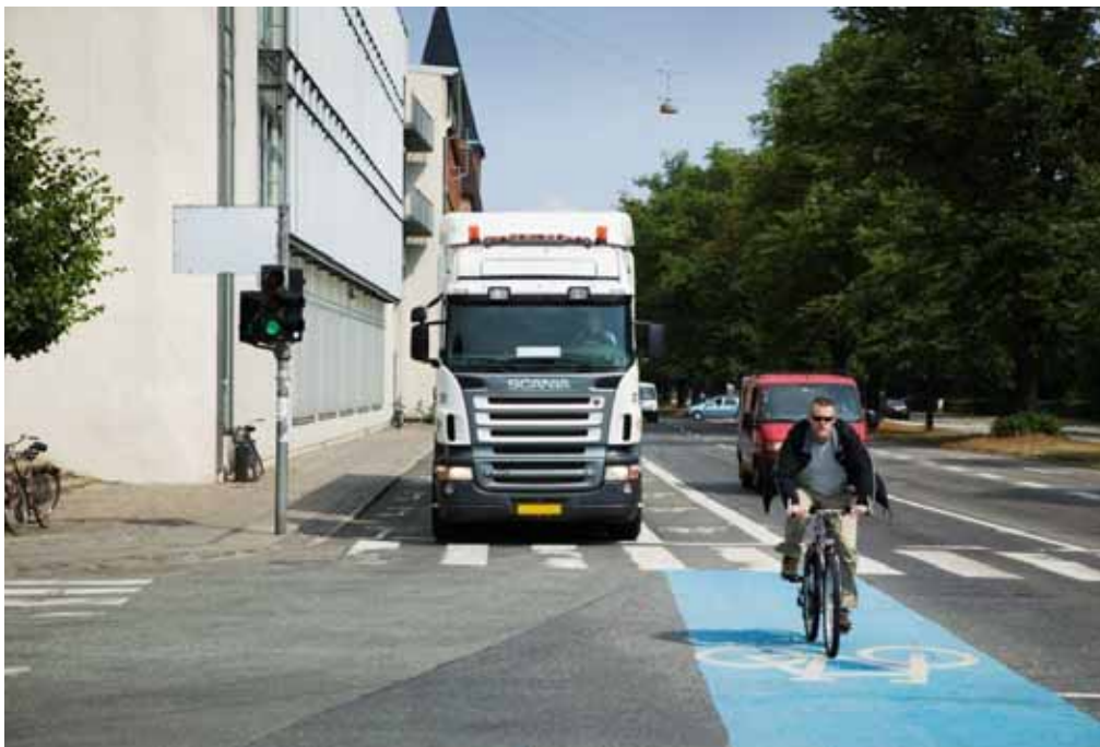
図表 1-55 安全性に配慮した自転車利用空間整備の例（巻き込みを予防する通行帯の移動）
