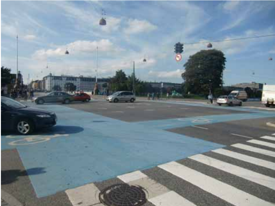
図表 1-54 安全性に配慮した自転車利用空間整備の例（交差点内もカラーリングする工夫）
