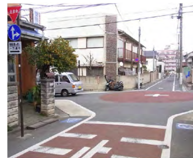
△カラー舗装による一時停止の注意喚起
