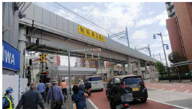
「高架化工事が進む竹ノ塚踏切」 * 令和2年9月撮影
