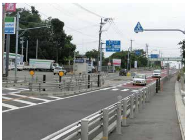
宮崎県児湯郡川南町平田地区について二段階横断施設の例
