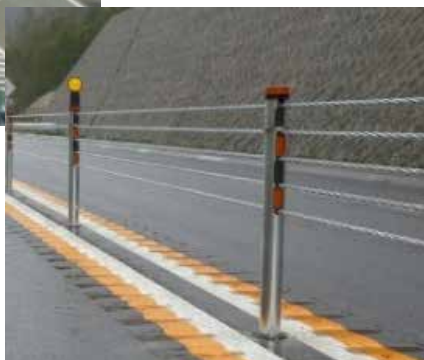
< ワイヤロープの設置事例 >
