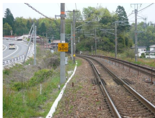
(写真3) 堀川踏切から上り方面を見る。カーブしているため、通行人からの見通しが悪い。2009年4月24日撮影
