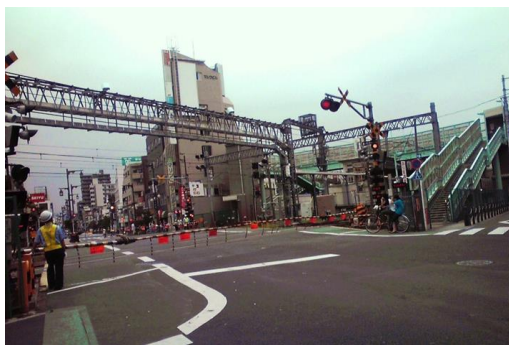
（写真 1）竹ノ塚 37 号踏切。事故後 2005 年 9 月に自動化され、2006 年 3 月には踏切横に歩道橋が設置された。
