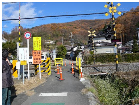
（写真5）遮断機が設置され、第1種踏切になった武津踏切。
