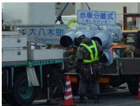
写真2 歩車分離信号プレートの取り付け 線規制をしたため、車が渋滞しましたが、作業の安全性や確実性を重視するためのやむ得ない渋滞です。つり下ろされた信号機の大きさにも驚かされました。
