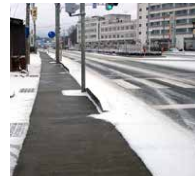
融雪装置(地中熱利用システムの例)
