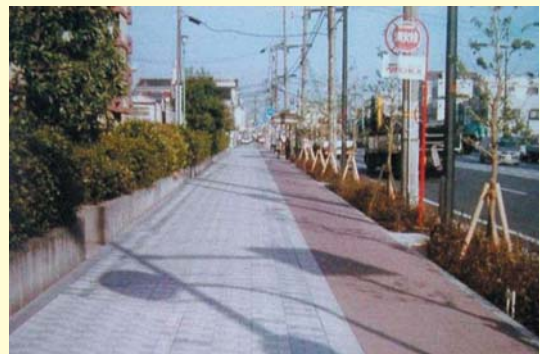
幅の広い歩道
