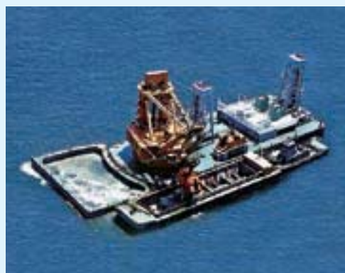
中山水道・浚渫状況
