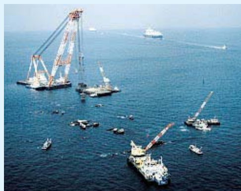
第三海堡・撤去状況
