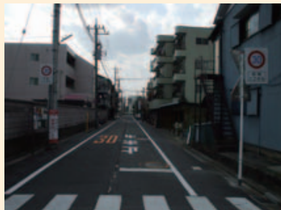
対策後（中央線を抹消し路側帯を設置：背板付き区域規制標識を設置）
