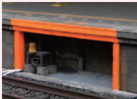
ホーム下の待避スペース
