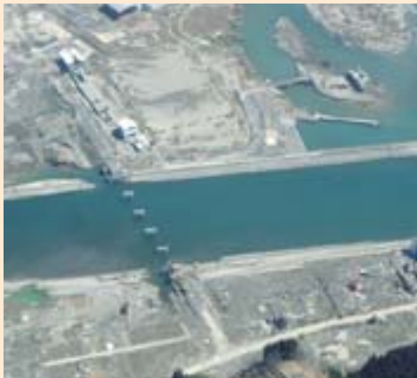
【被災直後の状況】
