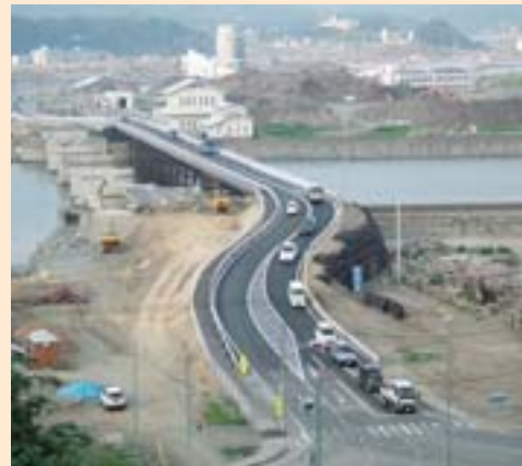
【仮橋開通後の状況】
