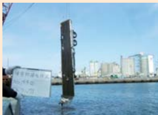
航路等の障害物（トレーラー）を取り除く啓開作業の様子（宮城県仙台塩釜港）
