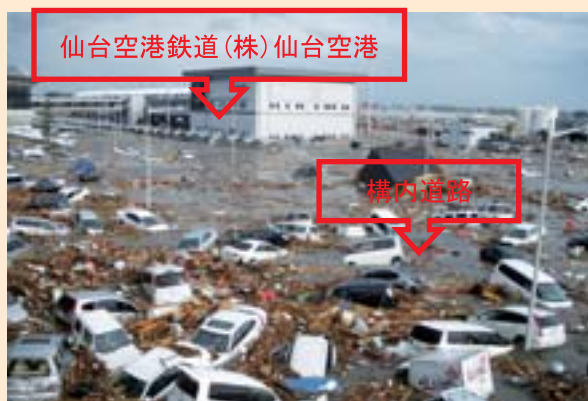
【被災直後の状況】
