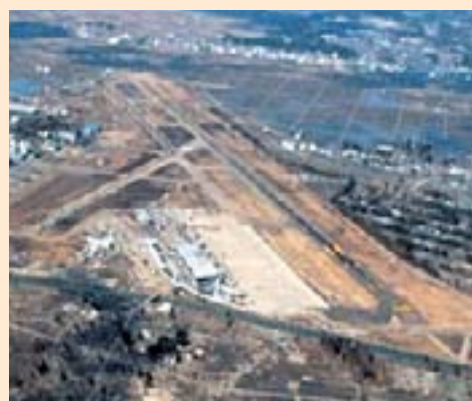
【復旧後の滑走路】
