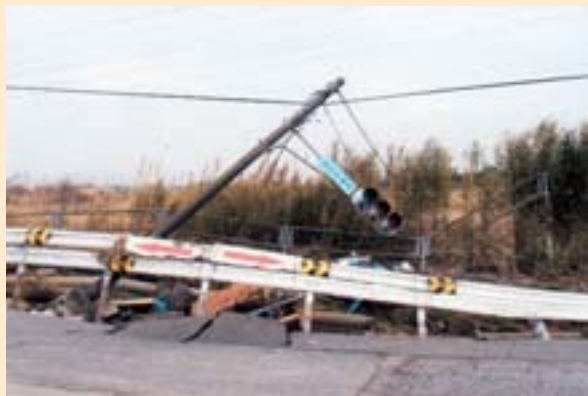
◇損壊した信号機（茨城県神栖市）
