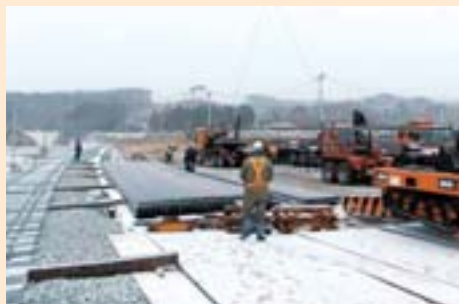
【レールの復旧作業時の様子】 (平成24年2月1日より敷設開始)
