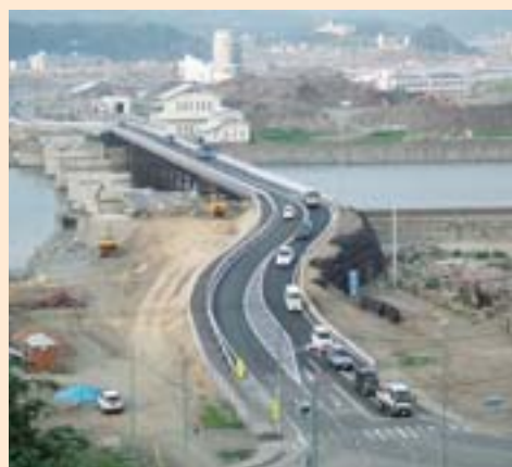
【仮橋開通後の状況】
