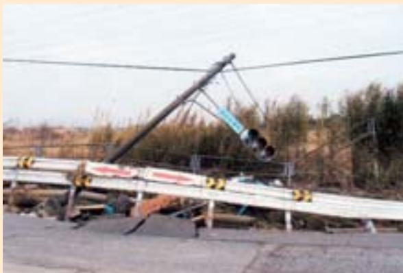
◇損壊した信号機（茨城県神栖市）
