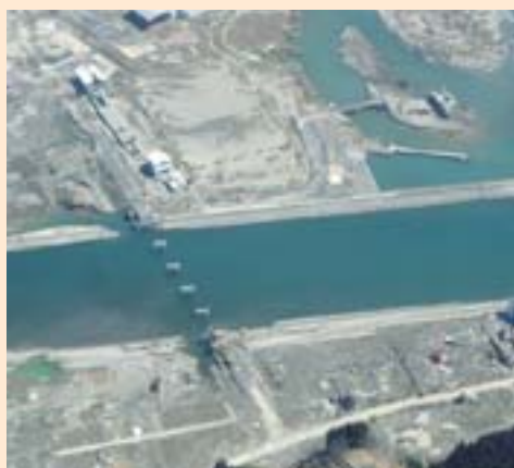
【被災直後の状況】
