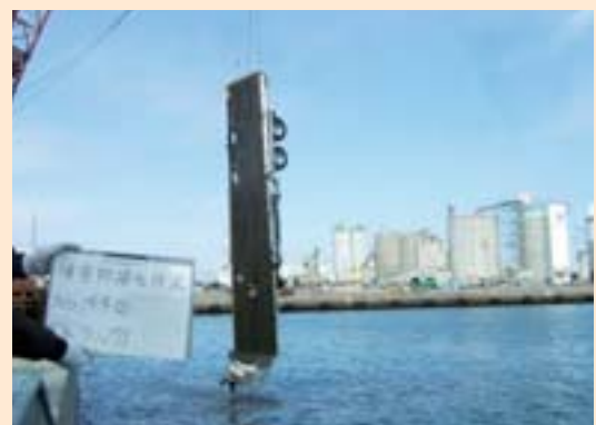
航路等の障害物（トレーラー）を取り除く啓開作業の様子（宮城県仙台塩釜港）
