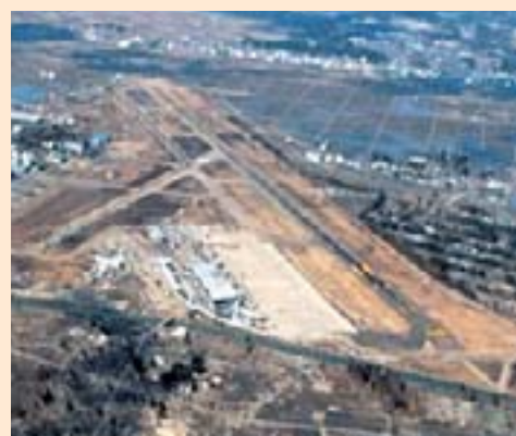
【復旧後の滑走路】
