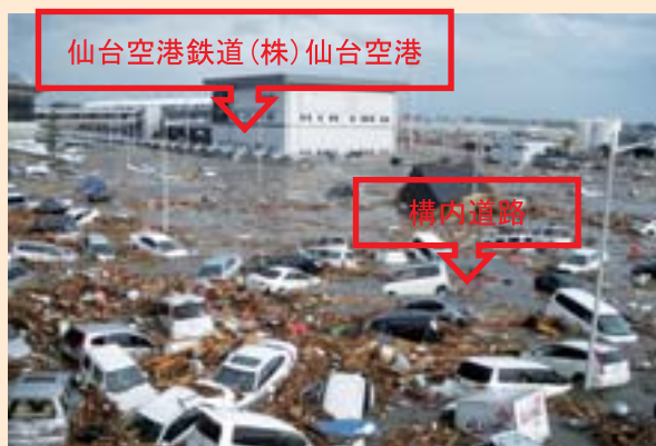
【被災直後の状況】
