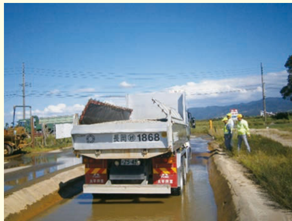
安全パトロール・ダンプカーの「足洗い場」
