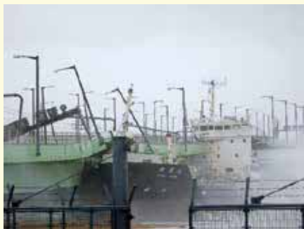
連絡橋に衝突した状況
