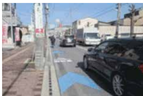
(矢羽根型路面表示の設置例)
