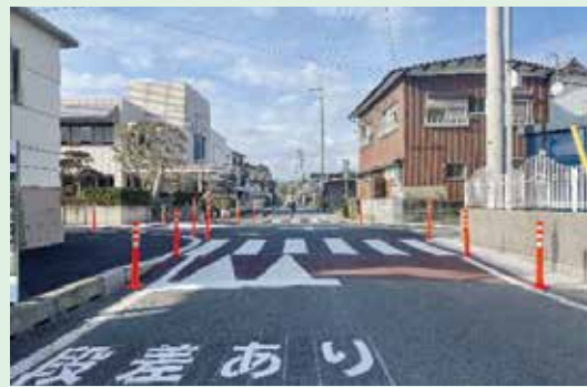
スムーズ横断歩道（交差点部） (高知県四万十市 中村小学校地区)
