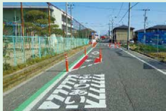
シケイン（クランク） (広島県福山市 新涯町一丁目・新涯町三丁目地区)
