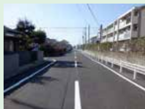
防護柵の設置
