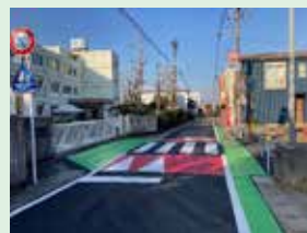
スムーズ横断歩道の設置
