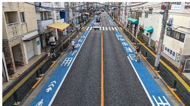
(普通自転車専用通行帯の整備)
