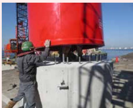
図7. 海水浸入防止対策工事の様子
