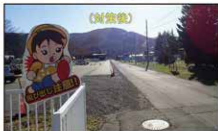
暫定的に注意喚起看板を設置
