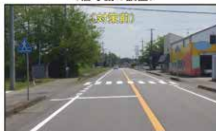
通行車両が多く、道路を安全に横断できない
