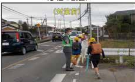
路側帯が狭く、通行することもと車両との間に十分な間隔が確保されない
