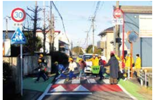
スムーズ横断歩道の設置例（岐阜県各務原市）
