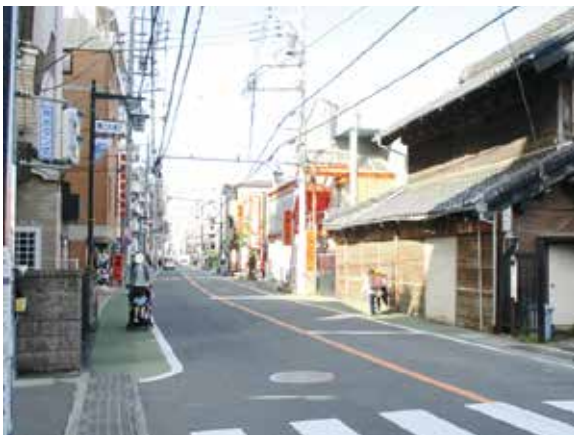
路肩のカラー舗装
