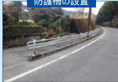
防護柵の設置
