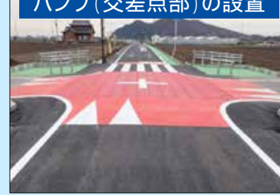
ハンプ(交差点部)の設置
