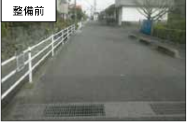
区画線の設置・カラー舗装
