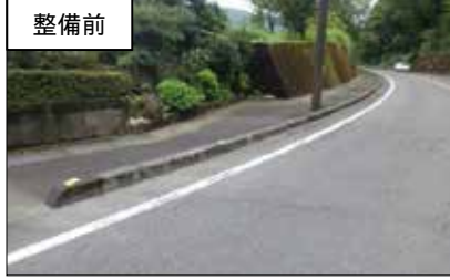
防護柵の設置
