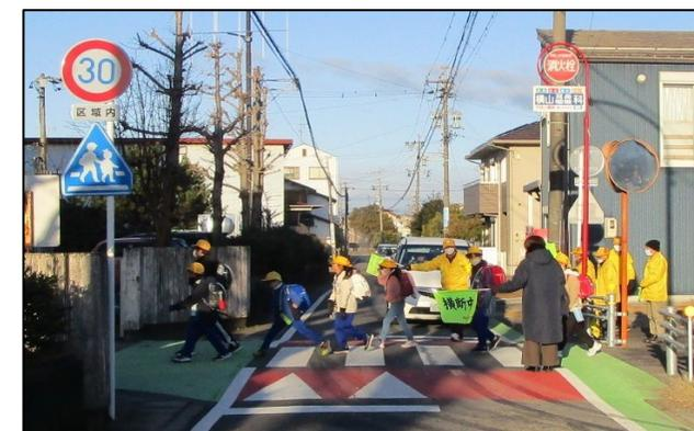
(対策後) 最高速度規制引下げ、スムーズ横断歩道の設置により、車両速度を抑制し、横断歩行者等の安全を確保
