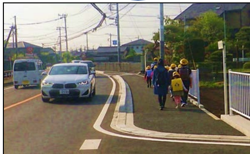
歩道の設置により、安全な歩行空間を確保
