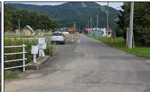
歩道の設置を計画しているが、完了までに一定期間を要する
