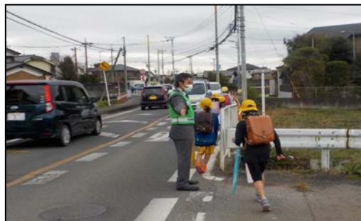
路側帯が狭く、通行することもと車両との間に十分な間隔がない
