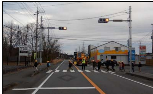
信号機の設置により、道路を安全に横断できる環境を整備
