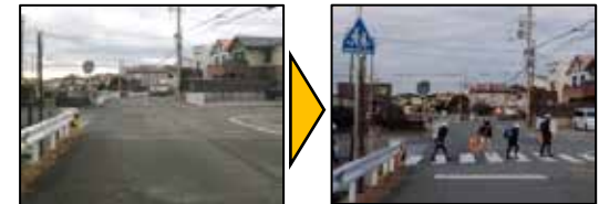
【横断歩道の設置】
