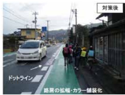
路肩のカラー拡幅 カラー舗装化
