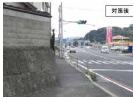
防護柵の設置
