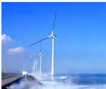
鹿島港の洋上風力発電 （ウィンドパワーかみす）
