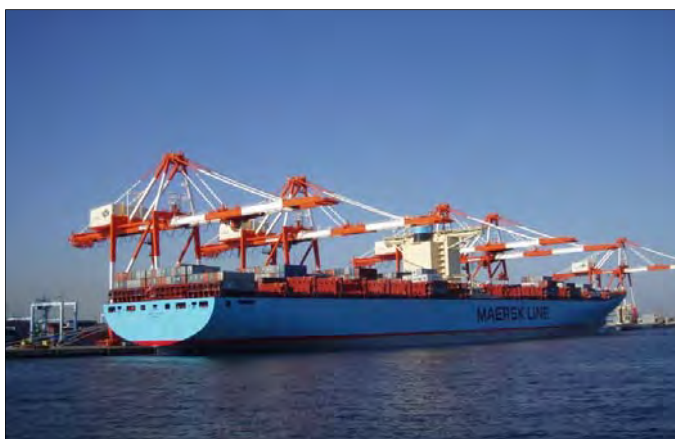
図 2 : 横浜港 南本牧コンテナターミナル (MC-2)
