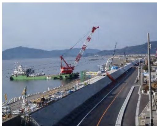
海岸堤防の耐震化工事(高知県高知海岸)
