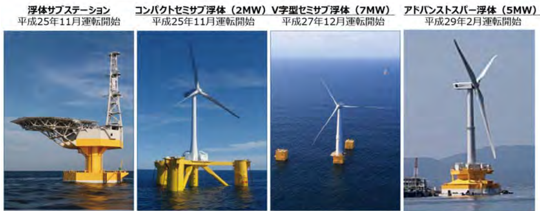
提供：福島洋上風力コンソーシアム
