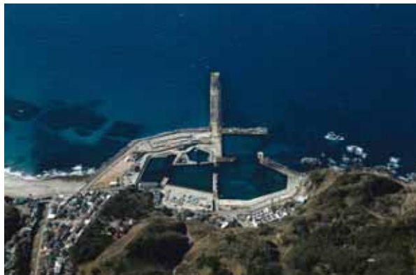
神津島港全景（伊豆諸島）
