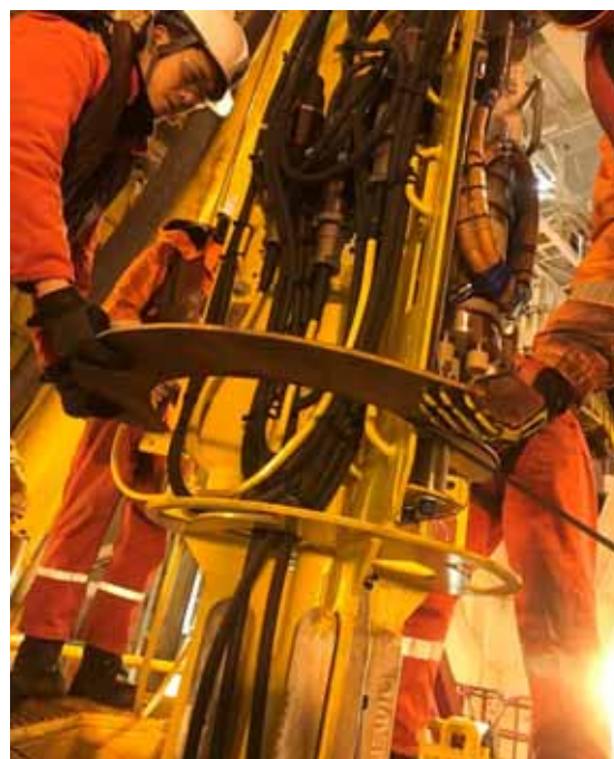
南海トラフの海底下に設置した 「長期孔内観測システム」の降下準備 提供：JAMSTEC / IODP
