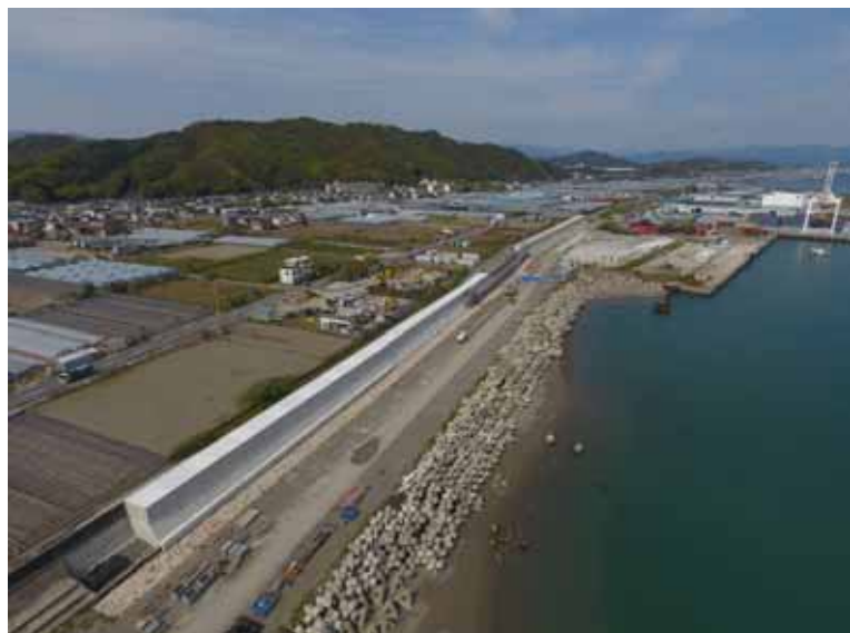
海岸堤防等の高潮・津波対策（高知港海岸） （提供：国土交通省）
