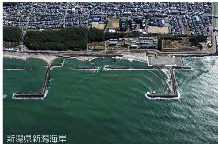
新潟県新潟海岸 突堤・人工リーフによる面的防護対策(提供:国土交通省)
