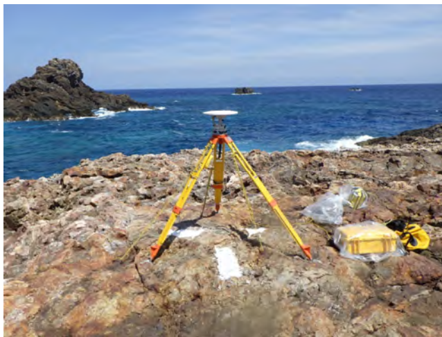
二等三角点「平瀬」における測量作業の様子 （提供：国土地理院）
