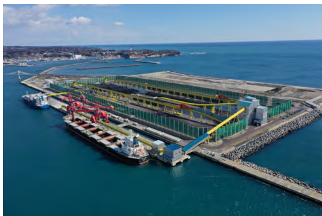
小名浜港国際物流ターミナルへの大型運搬船の接岸状況 （提供：国土交通省）
