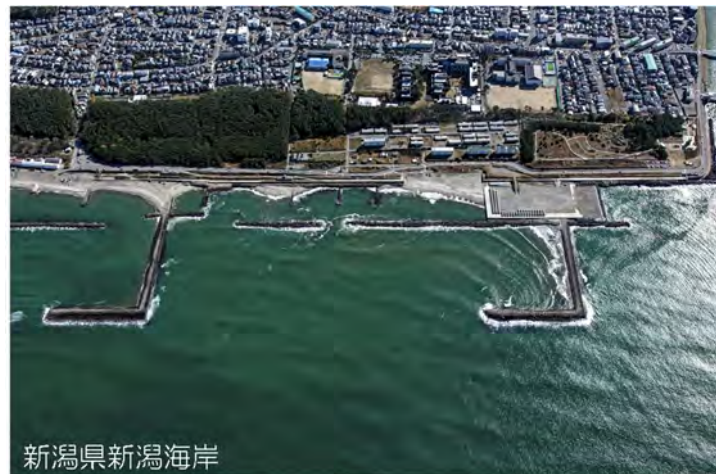
突堤・人工リーフによる面的防護対策（提供：国土交通省）
