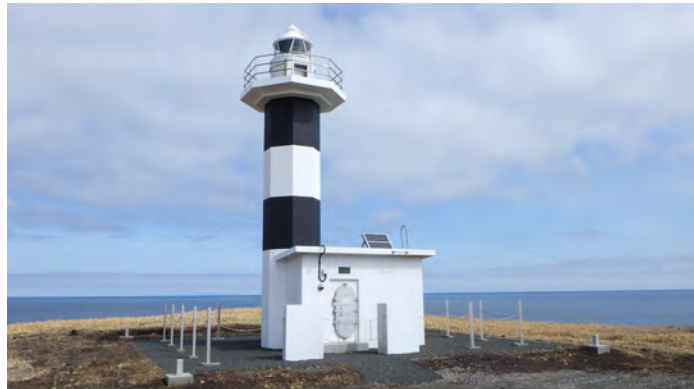
耐震補強実施後のノッカマップ埼灯台（北海道） （提供：海上保安庁）
