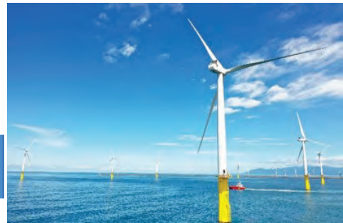
能代港内の風車据付完了 提供：秋田洋上風力発電（株）
