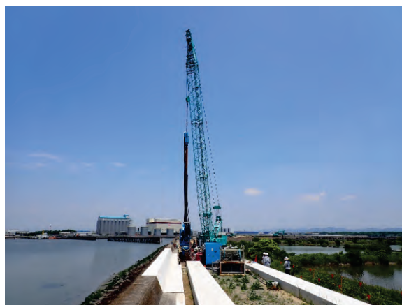
海岸堤防の耐震対応の状況
