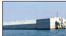
上部工の嵩上げ
