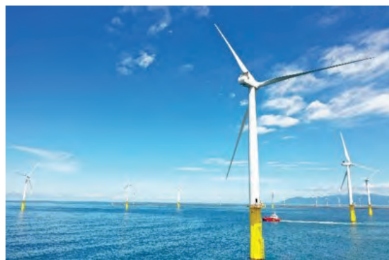
能代港内の風車据付完了 （提供：秋田洋上風力発電（株））
