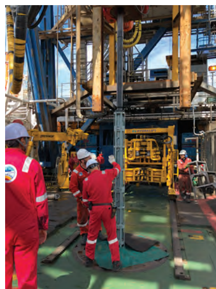
長期孔内観測システムの センサー部分 (提供：JAMSTEC)
