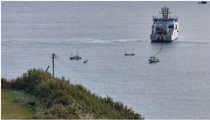
ケーブル敷設船を用いた南海トラフ海底地震津波観測網（N-net）のケーブル陸揚げ時の様子 （提供：防災科学技術研究所）
