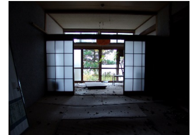
老朽化したホテル・旅館の改修
