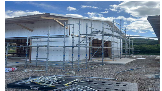
【大工作業用足場の組立】
