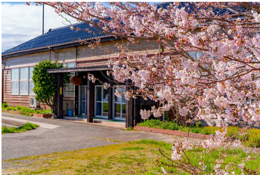
学校蔵(旧西三川小学校校舎)
