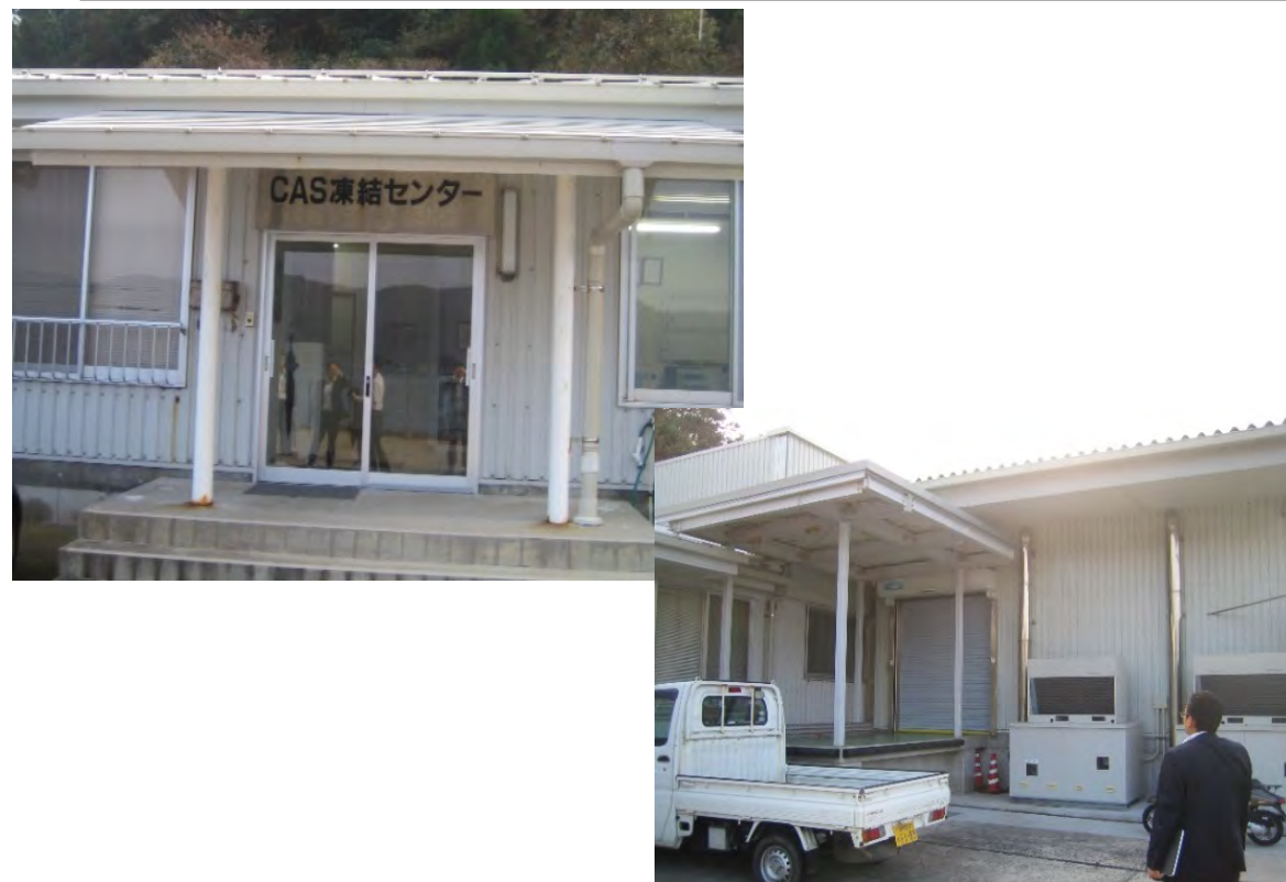
CAS凍結センターの外観
