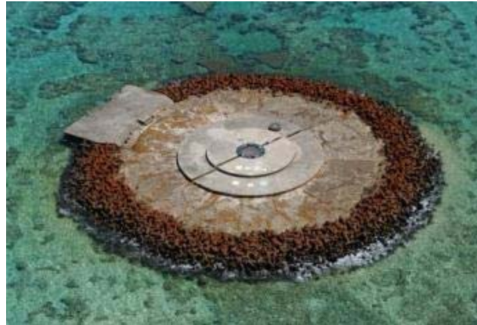
東小島全景(平成19年撮影)
