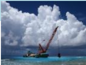
南鳥島における浚渫工事の状況
