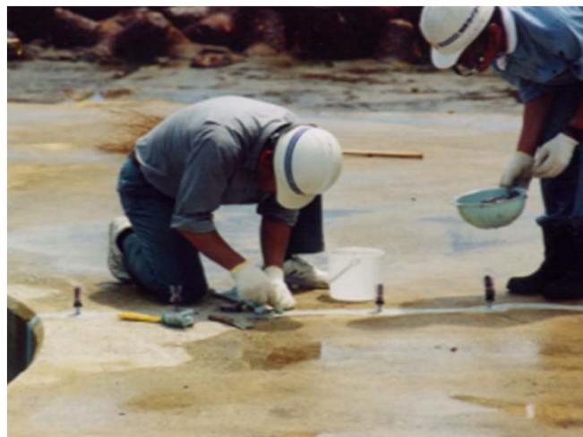
クラックの補修状況(注入工)
