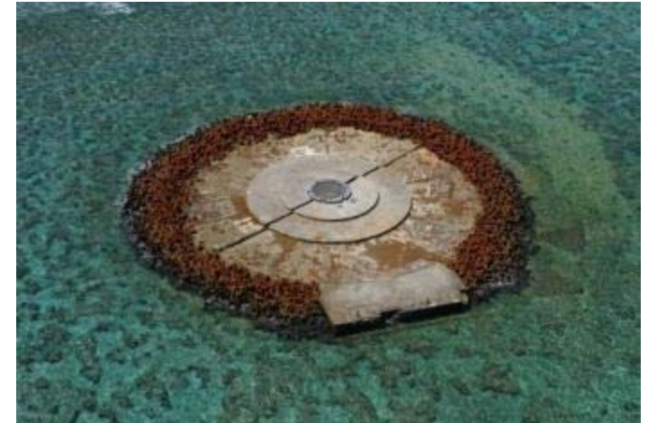
北小島護岸全景(平成19年撮影)
