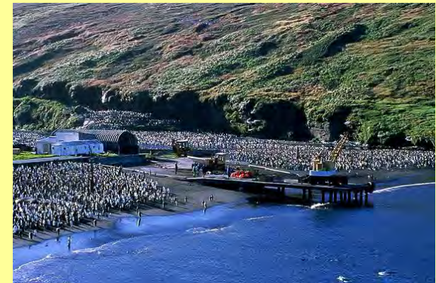
アムステルダム島の係留施設と研究所
