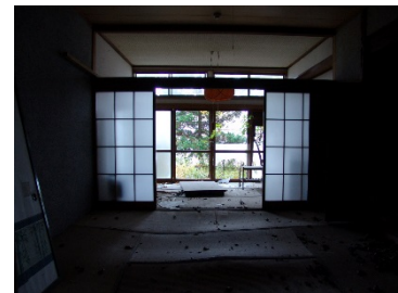
老朽化したホテル・旅館の改修
