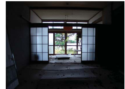
老朽化したホテル・旅館の改修
