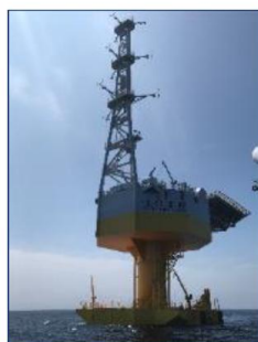
ふくしま絆（洋上変電所）
